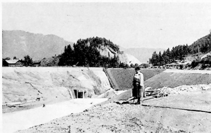
Abb. 1. Das Ausgleichsbecken des Salzachkraftwerkes bei Schwarzach gegen Osten. In Bildmitte der Brandstattbühel.
